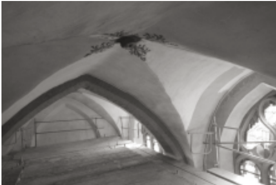
Gewölbe im Chor nach der Reinigung mit der Schwamtechnik
