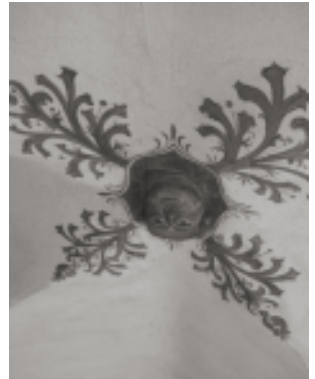
Schlussstein im Gewölbe
