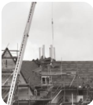
Der untere Teil des neuen Dachreiters, ca 6 Meter hoch, ist bereits auf dem Gewölbe des Chors wieder aufgebaut und ragt ca 2 Meter über das Dach hinaus.
