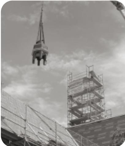
Der Dachreiter wurde danach in drei Einzelteilen zur Fa. Haveloh nach Ahaus transportiert und wird dort mit den Originalmaßen, wie vom Denkmalamt gefordert, auf dem Richtplatz wieder aufgebaut. Die Montage des neuen Dachreiters erfolgt dann vor Ort in umgekehrter Reihenfolge mit Hilfe des bewährten Autokrans. Das Gerüst wird ebenfalls in Teilschritten wieder aufgebaut bis zur Turmspitze.
