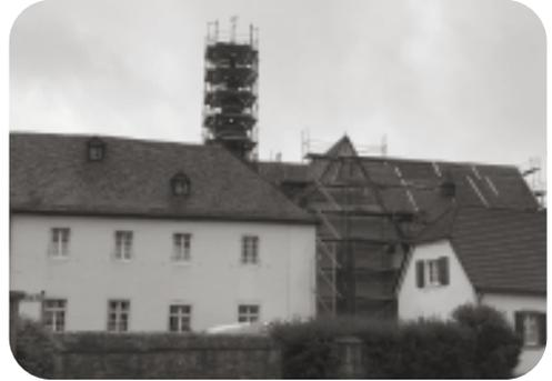
Um den Zimmerern den Abriss des 15 m hohen Dachreiters gefahrlos zu ermöglichen, wurde ein Spezialgerüst um den 15 Meter hohen Dachreiter aufgebaut. Parallel zum Abriss des Dachreiters wurde das Gerüst wieder zurückgebaut.
