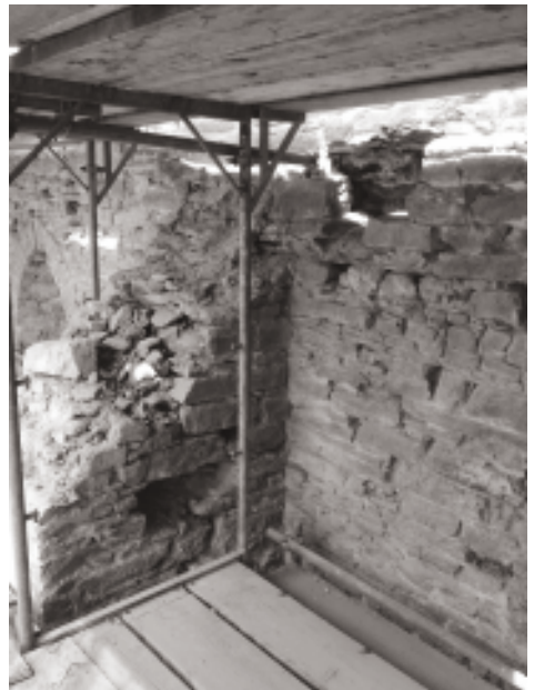
Schadensbild der Südseite
